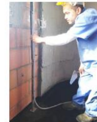
Foto 16: Execução de talisca com nível alemão.
