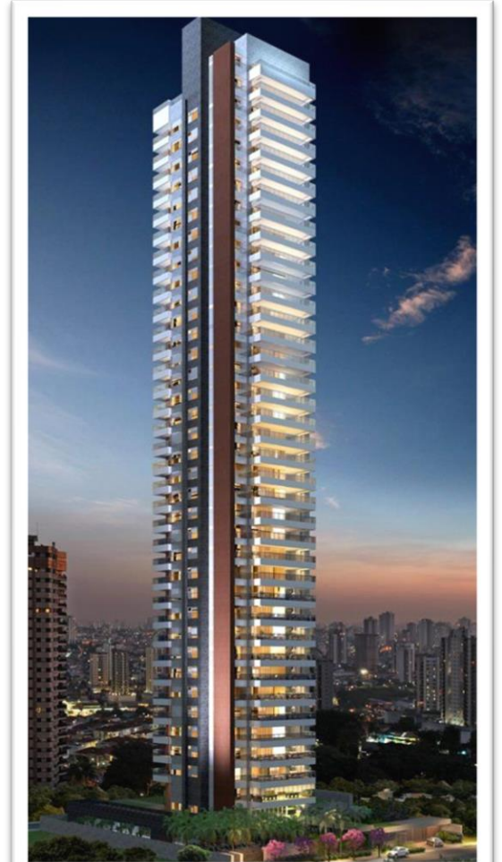
Porte Residencial Figueira
