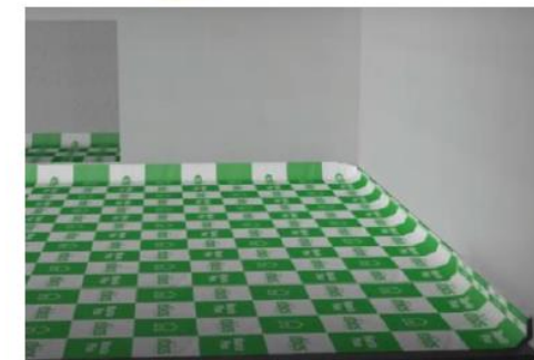
Figura 13: Detalhe da manta do rodapé e piso.
