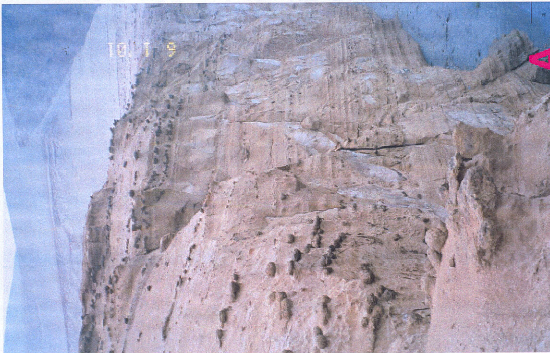
A. Vista panorámica de capas gruesas de areniscas calcáreas fosilíferas que se parecen a concreciones.
