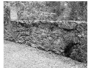
Abb. 137: Davos, Filisur, Wiesen, Alte Zügenstrasse. Bogenbrücke über den Sägenbach nach der jüngsten Instandstellung. Ersatz der fehlenden Brüstung nach historischem Vorbild.
