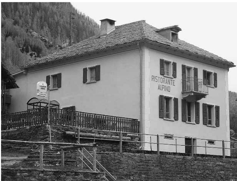
controllo della carpenteria esistente con la relativa sostituzione delle parti lignee danneggiate. La caratteristica *gronda romana* in legno è stata mantenuta. La nuova copertura in piode è stata eseguita cercando di riutilizzare il più possibile il materiale di recupero. Gli abbaini sono stati sostituiti. Tutti i lavori di lattoniere e di copertura dell'annesso, sono stati eseguiti in lamiera di zinco-titanio.
