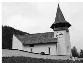
Das aus spätgotischer Zeit stammende Kirchlein erhielt erstmals nach der Reparatur der Lawinenschäden 1968 einen neuen Aussenanstrich (mit Kalk). Gleichzeitig wurden am Holzwerk des Turms kleinere Reparaturen ausgeführt.
