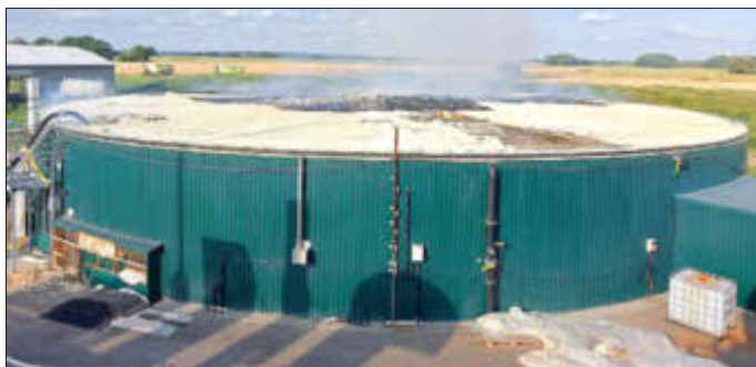
Die Biogasanlage in Dambeck
