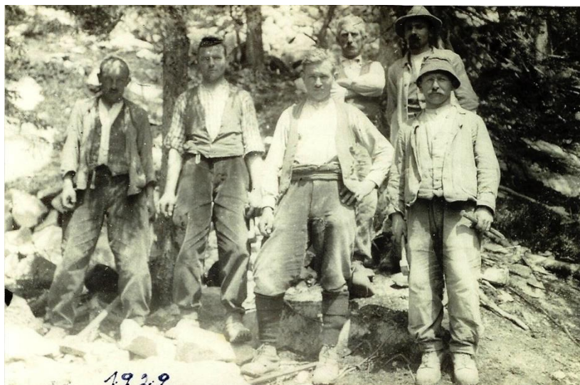
Abb. 24. Plattenbruch Arbeiter im Grächner Wald 1929. Foto: Archiv Kurt Brigger
