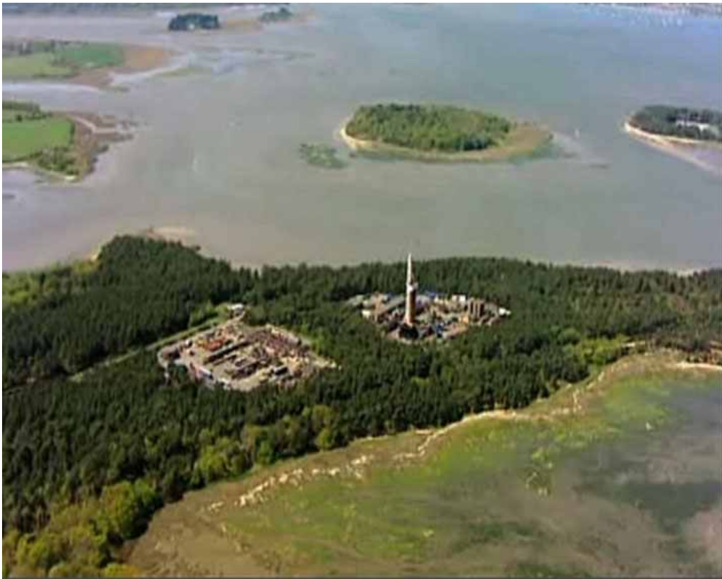
Εικόνα Π9. Άποψη των εγκαταστάσεων εκμετάλλευσης Υ/Α στο Wytch Farm.
