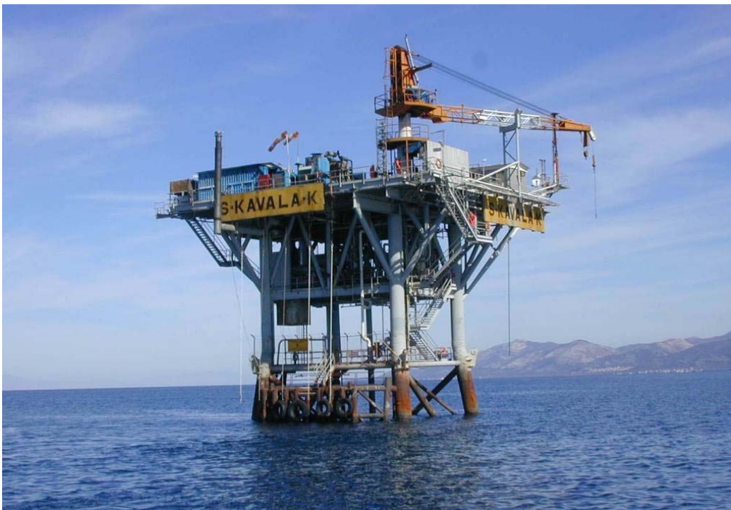
Εικόνα Π4. Η εγκατεστημένη εξέδρα παραγωγής φυσικού αερίου από το κοίτασμα Νότιο Καβάλας (πηγή: http://www.kavalaoil.gr/ )
