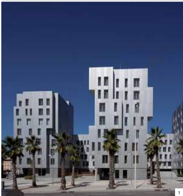
1_Edifici d'habitatges, locals i aparcament al carrer de Bilbao de Barcelona.
