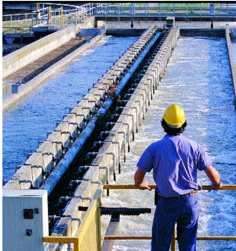
Impianto di depurazione di Roma Sud
