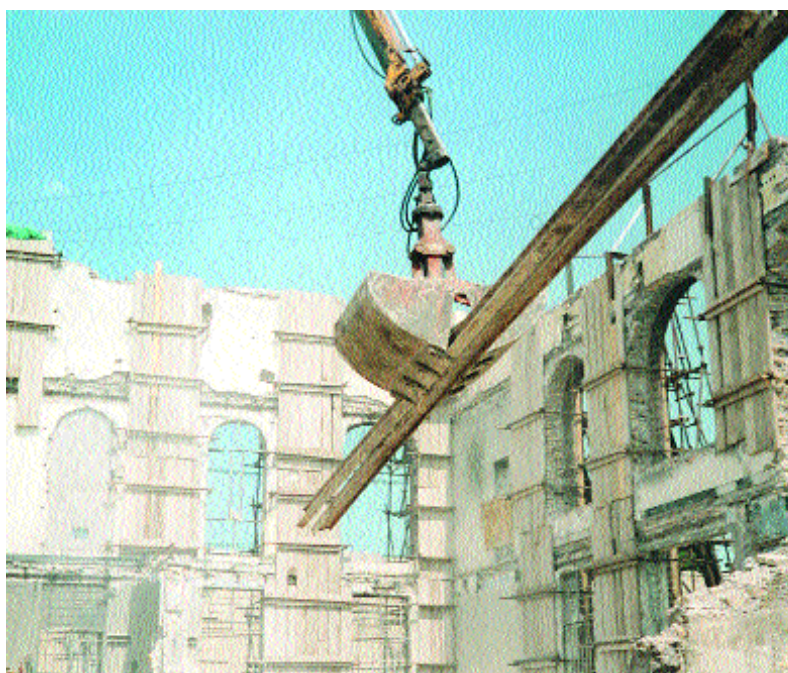
La ristrutturazione dell'ex Centrale del Latte
