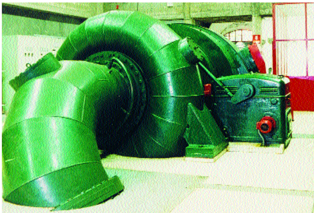
Centrale di Salisano: il gruppo turbina-alternatore da 23 MW
