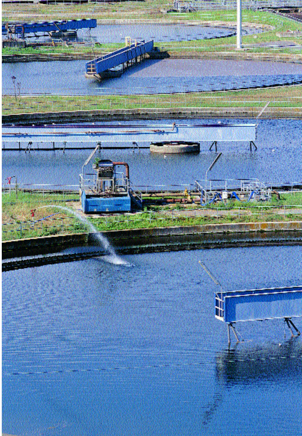
Impianto di depurazione di Roma Sud
