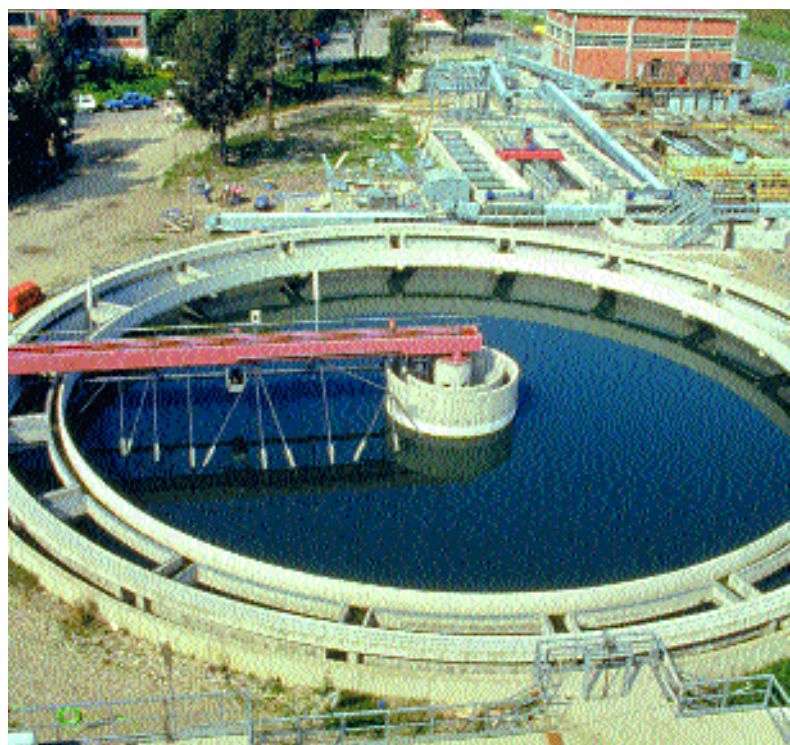
Impianto di depurazione di Roma Ostia
