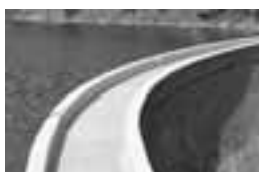
p.134, 2001, Acquedotti genovesi, diga di Lago Lungo
