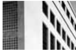
p.85, Anni Ottanta, CM, sala caldaie, esterni
