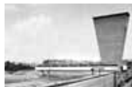
p.106, 1960, CIM, serbatoi, sotterraneo e sopraelevato
