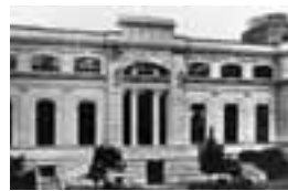
p.68, 1930, Centrale Montemartini, facciata principale
