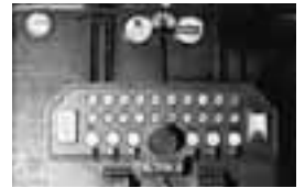
p.88, 1932, CM, sala macchine, quadro di manovra
