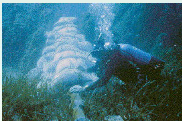
Posa di un cavo in prossimità della costa.
