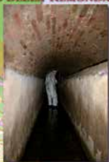
CUNICOLO DELLA REMONDA
