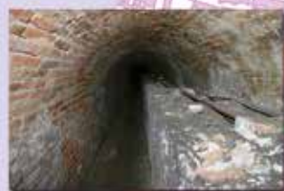
CUNICOLO DEL NETTUNO
