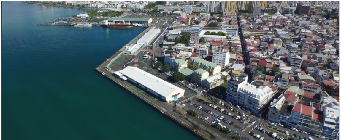
Figure 24 : Photo aérienne du port de Pointe-à-Pitre
