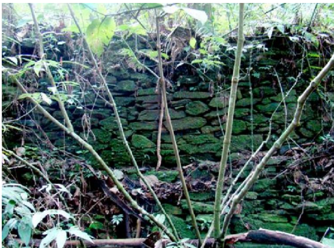
Foto nº 4b.20 - Muro de pedra seca edificado para contenção de encosta. Fonte: Prefeitura de Guarulhos, 2008.
