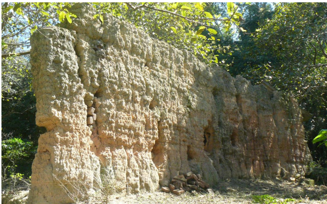
Foto nº 4b.03 - Parede de Taipa-de-Pilão próximo a casa. Fonte: acervo próprio, 2019.
