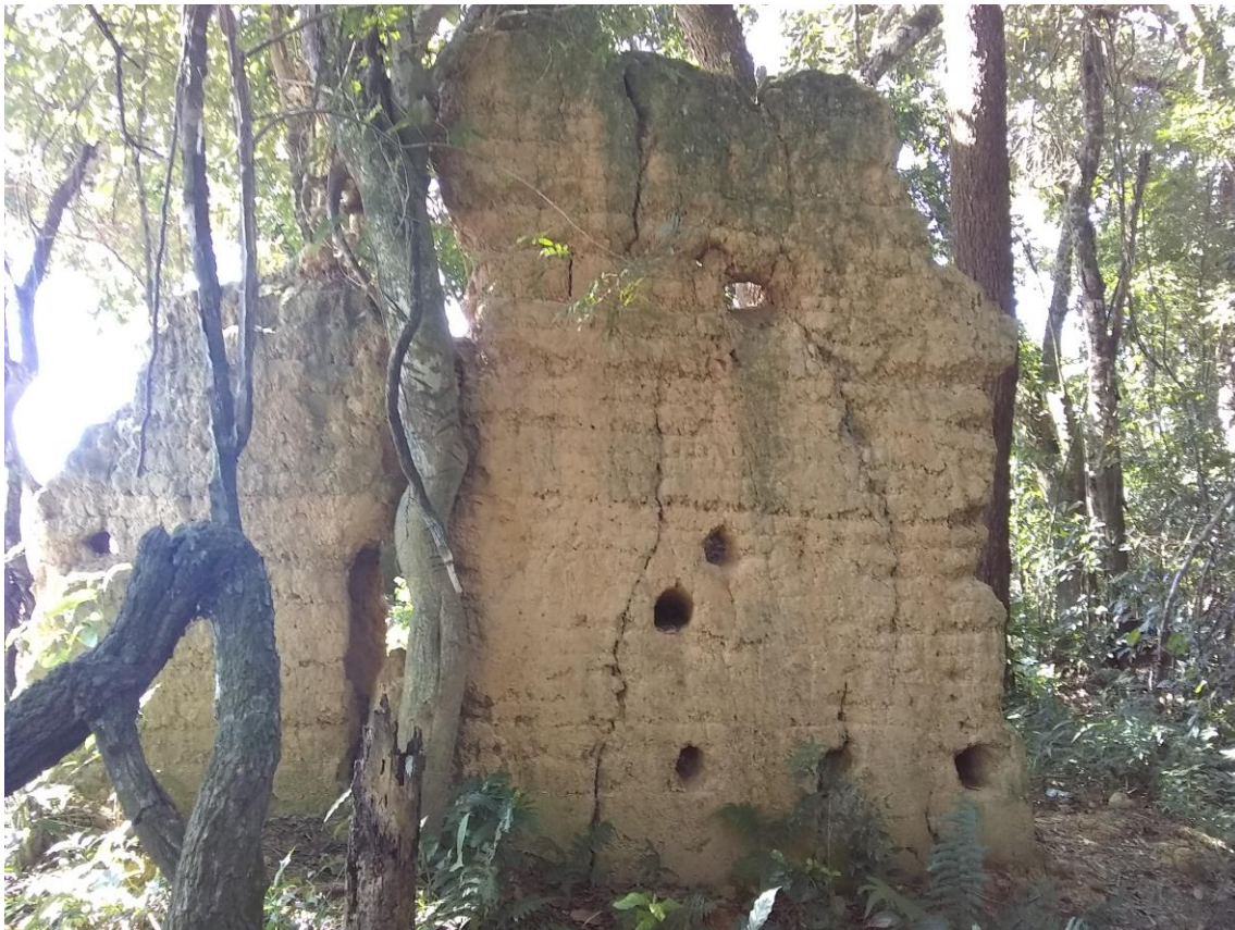
Foto nº 4b.09 - Parede de Taipa de Pilão. Fonte: acervo próprio, 2019.
