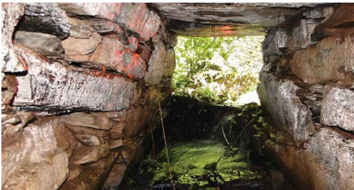
Foto nº 4b.17 - Duto de pedra de 96 m de comprimento usado para o encaminhamento de água para a mineração aurífera.
