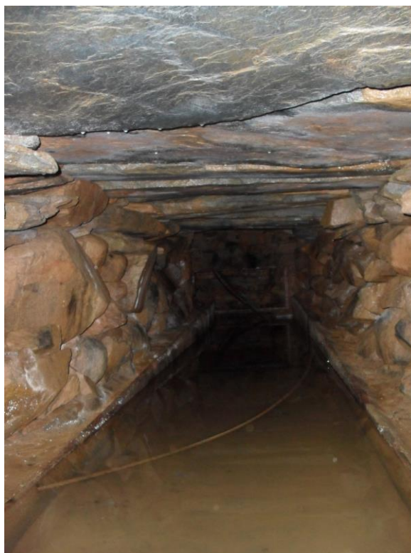
Foto nº 4b.16 - Canal tamponado constituído de pedra seca. Fonte: Prefeitura de Guarulhos, 2011.
