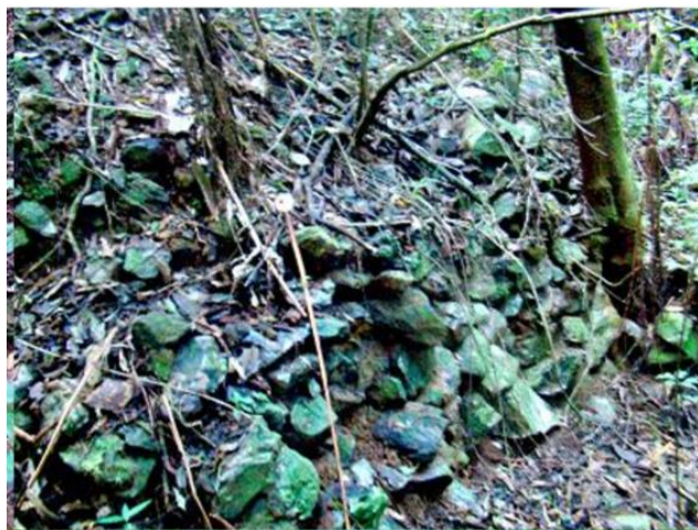
Foto nº 4b.19 - Contenção de encosta Lavras. Fonte: Prefeitura de Guarulhos, 2008.
