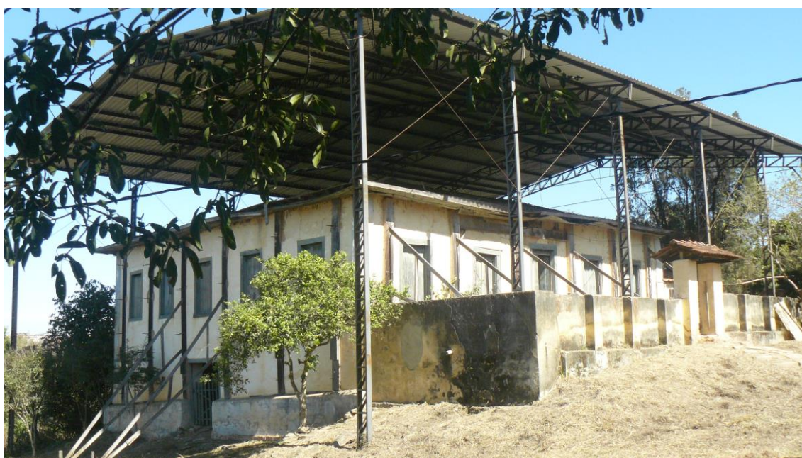
Foto nº 4b.02 - Casa da Candinha (com o reforço estrutural de madeira e a cobertura metálica) Fonte: acervo próprio, 2019.
