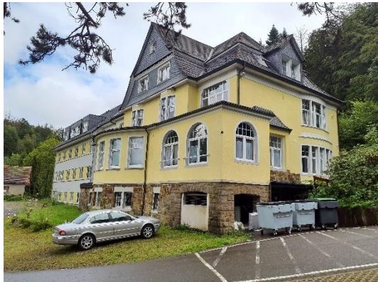
Abb. 4 Gebäude des Plangebietes.
