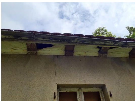
Abb. 10 Öffnung zum Dachstuhl.
