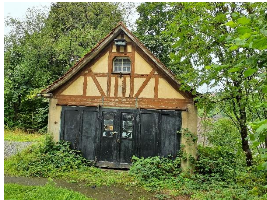
Abb. 5 Gebäude an der Zufahrt.
