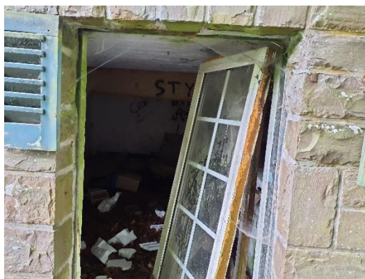
Abb. 11 Öffnung zum Innenraum.
