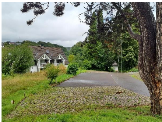
Abb. 6 Verkehrsflächen im Plangebiet.
