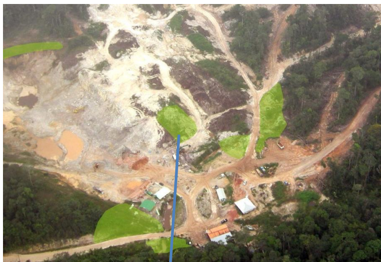
Figure 70 : Exemple de travaux de terrassement et replantations opérés en 2012 sur la carrière du Galion
