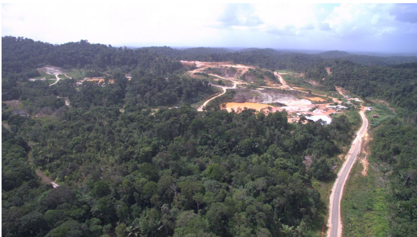
Figure 49 : Angle de vue aérien depuis l'entrée de la piste d'accès
