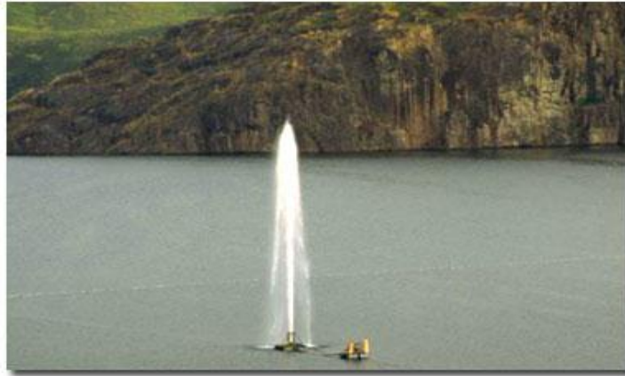
Figure 13 : Système de dégazage artificiel du Lac Nyos
