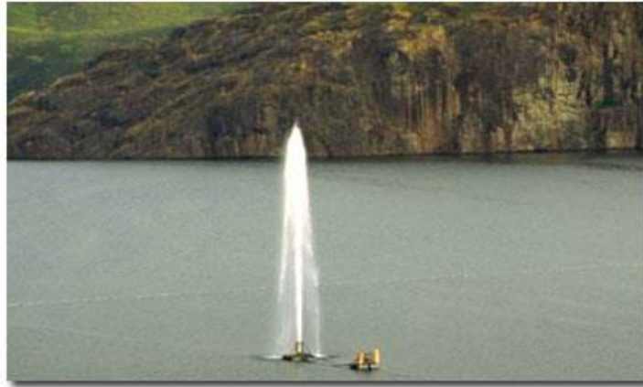
Figure 13 : Système de dégazage artificiel du Lac Nyos
