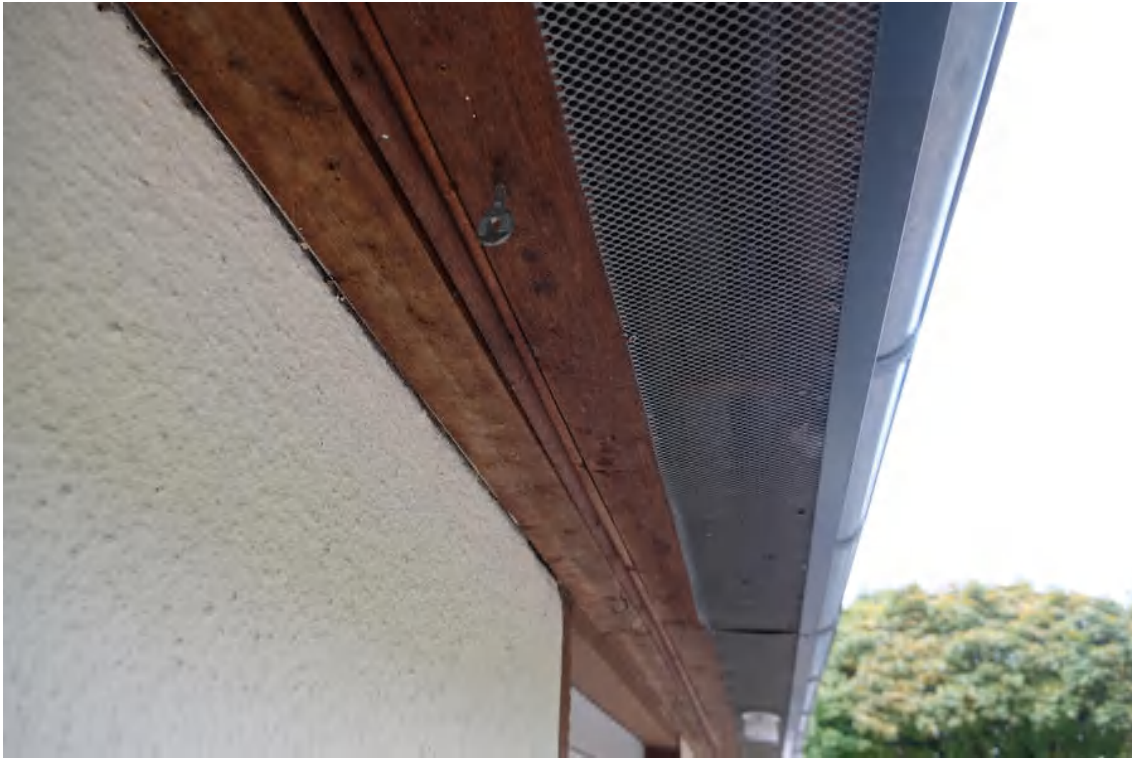
Abb. 6: Dachtraufe des Markanaheims
