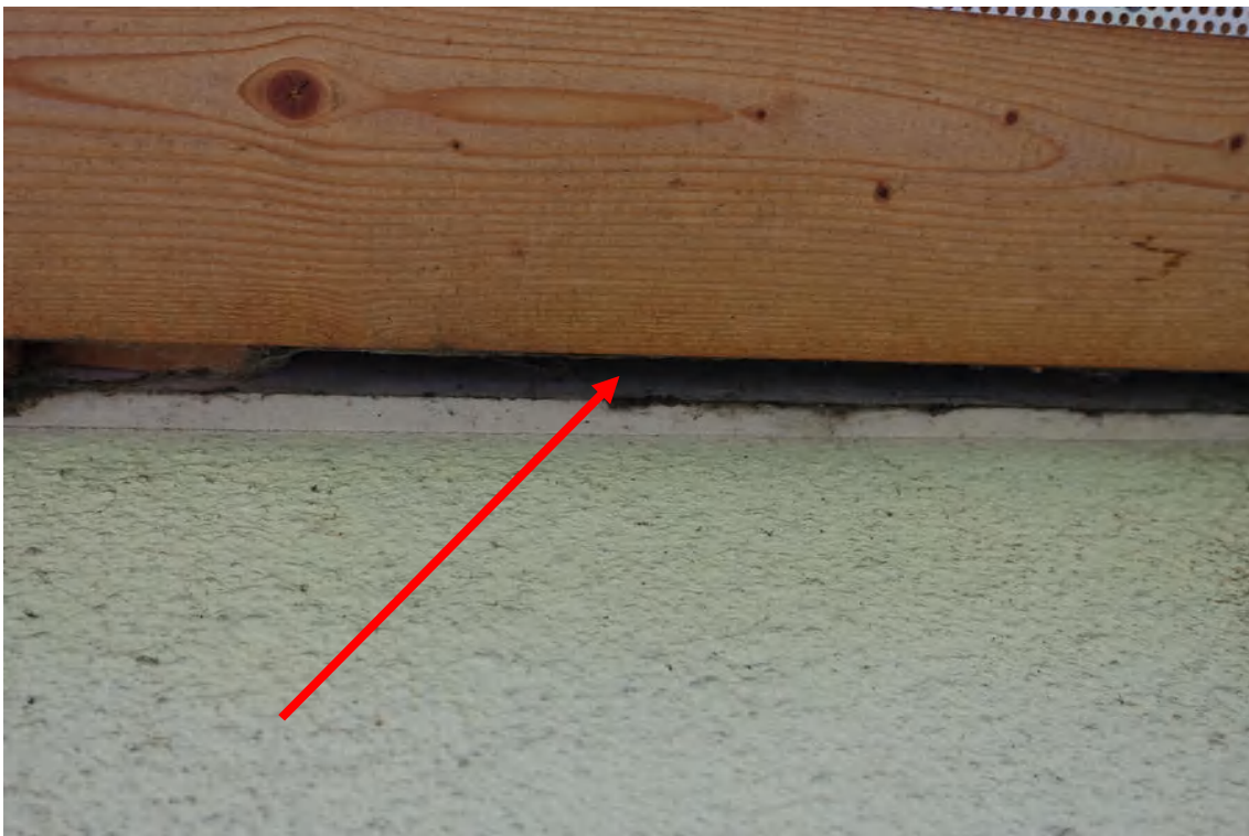
Abb. 7: Spalt zwischen Fassade und Traufkasten
