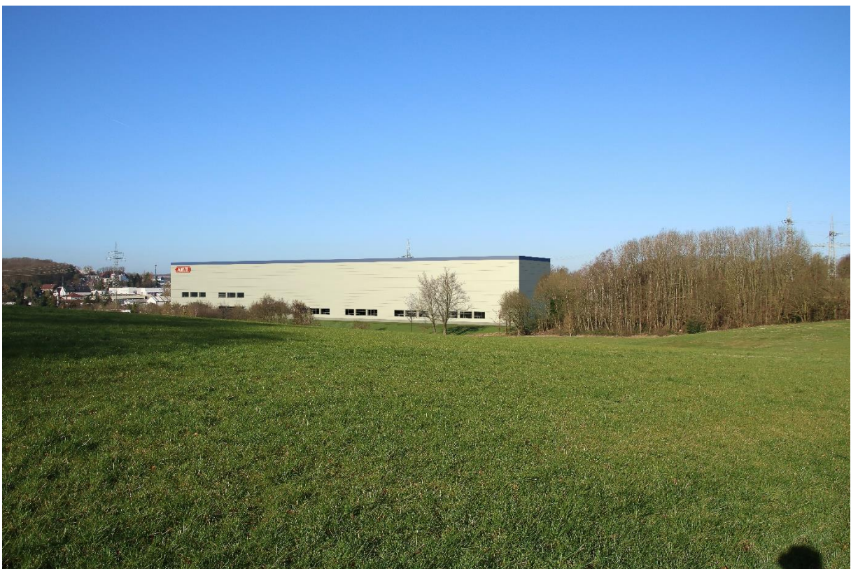
Abb. 3.18: Vergleich des Istzustandes (oben) mit dem visuellen Eindruck des Hochregallagers von der Freifläche auf Kuppenlage
