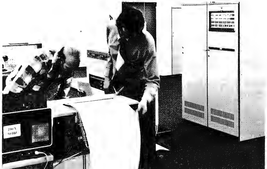
Im geschützten Rechnerraum ist der Prozessrechner, zwei Magnetplattenstationen, der Zeilendrucker sowie die notwendigen Steuer- und Hilfseinrichtungen untergebracht.
