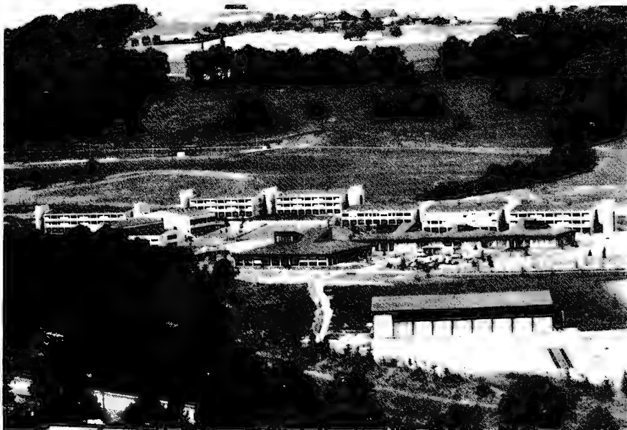
La nouvelle caserne à Moudon
