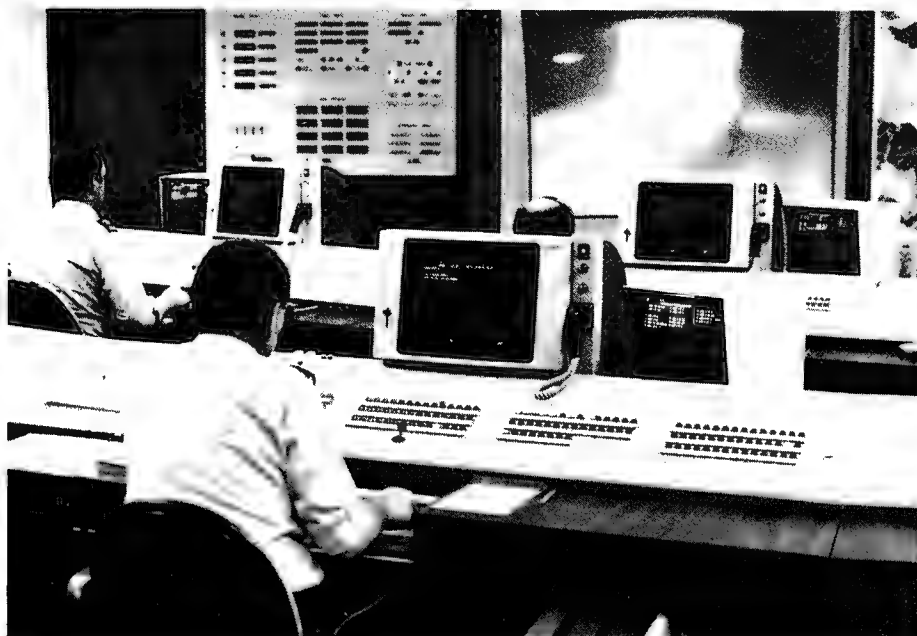
Kernstück jedes Arbeitsplatzes bilden der Hauptdatenmonitor und das Eingabetastenfeld (verdeckt im Bild). In der Schräge des Pultes liegen alle Tasten für die Steuerung der nachrichtentechnischen Anlagen. Ganz im Hintergrund ist links das gesamte Alarmanzeigefeld und rechts davon ein Videoprojektor sichtbar.
