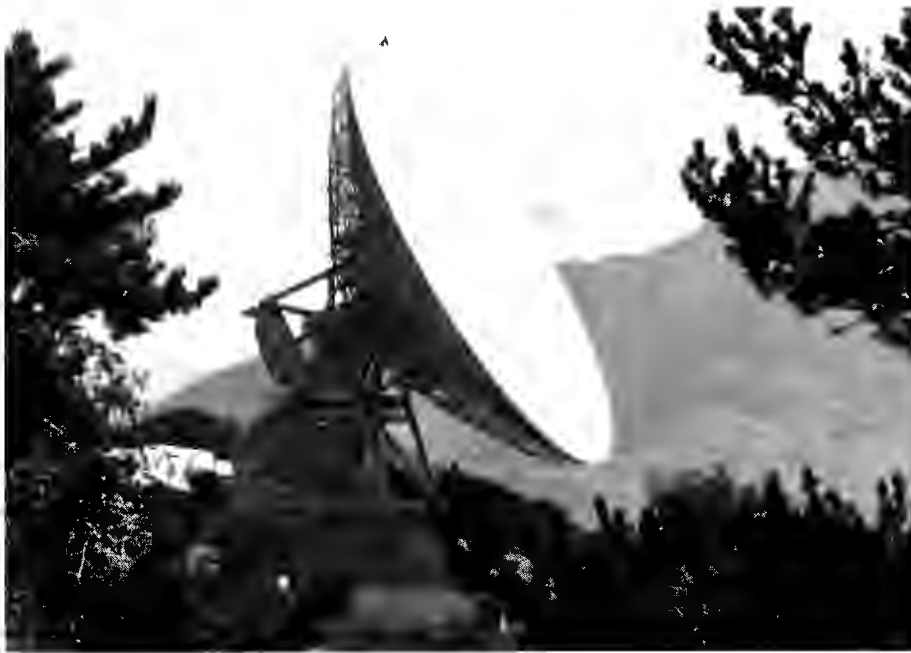
Die rund 30 Meter grossen Parabolantennen der Bodenstation Leuk VS wiegen (ohne Antennensockel) 400 Tonnen.
