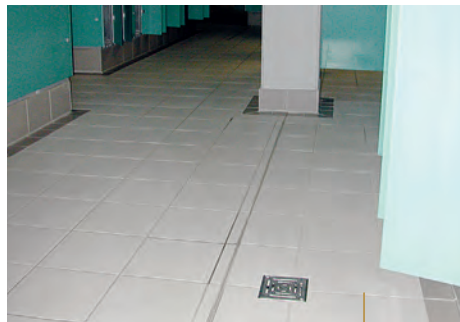
Rohrdurchführung, Bodenablauf, Gefälle
