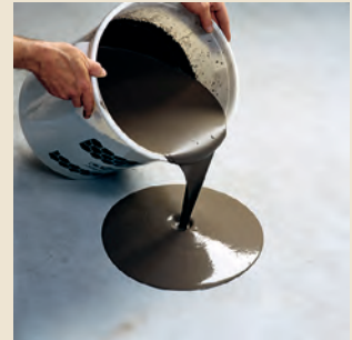
3 Im angegebenen Verhältnis gemischt, ist die Masse selbstverlaufend
