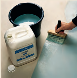
1 Grundierung als Haftbrücke
