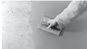
Aufbringen einer standfesten Betonspachtelmasse
