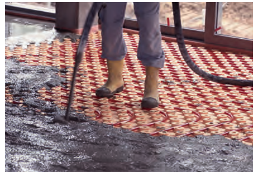
Einbringen mit der Mörtelpumpe
