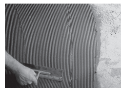
Einseitiges Auftragen: Zuerst wird eine Kontaktschicht aufgetragen und darauf „frisch in frisch“ das Dünnbett aufgekämmt
