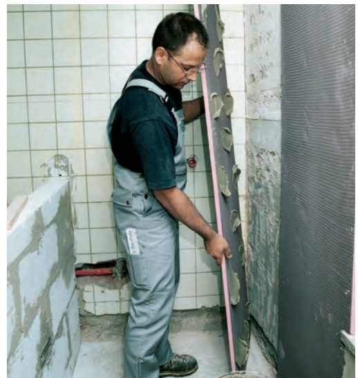
Herstellen eines ebenen Untergrundes mit bewehrten Hartschaumplatten
