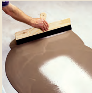
5 Verteilung mit dem Schweden-Rakel
