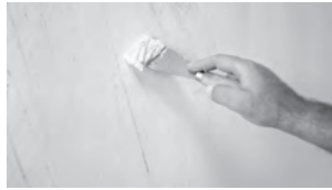
Entfernen eines alten Anstrichs nach der Vorbehandlung mit Lackqueller
