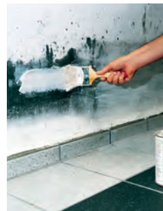
Auftragen der Entölerpaste
