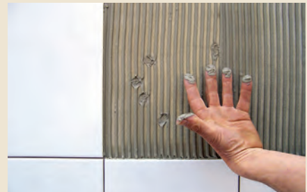
Haftet der Kleber an den Fingern, können Fliesen angesetzt werden
