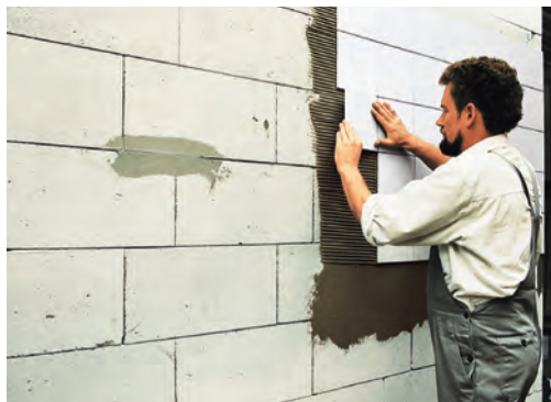
Einschieben der Fliesen
