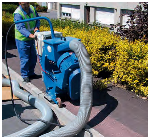
Herstellen eines griffigen und sauberen Betonuntergrundes mittels Kugelstrahlen (Blastrac-Verfahren)
