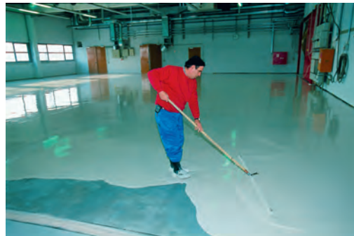
Abziehen eines fugenlos eingebrachten Magnesiaestrichs
