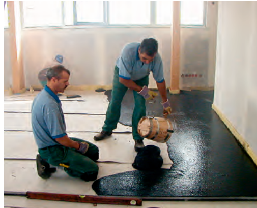
Einbau von Gussasphaltestrich auf Dämmschicht
