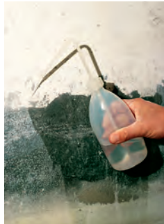
Auftragen des Entölers
