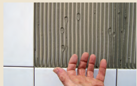
Bleiben die Finger sauber, ist die offene Zeit überschritten. Der Kleber muss entfernt und ein frisches Klebebett aufgezogen werden
