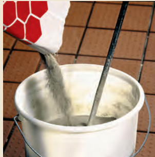
2 Anrühren bei ca. 600 Umdrehungen pro Minute
