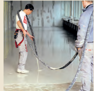
6 Pumptechnik bei Großflächen
