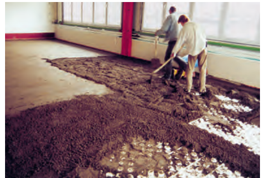
Estrich: Einbringen in plastischem Zustand
