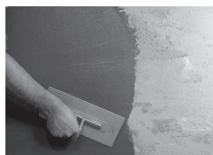
Einseitiges Auftragen: Zuerst wird eine Kontaktschicht aufgetragen und darauf „frisch in frisch“ das Dünnbett aufgekämmt
