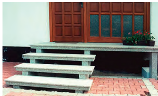
Außentreppe, hier: Balkentreppe
