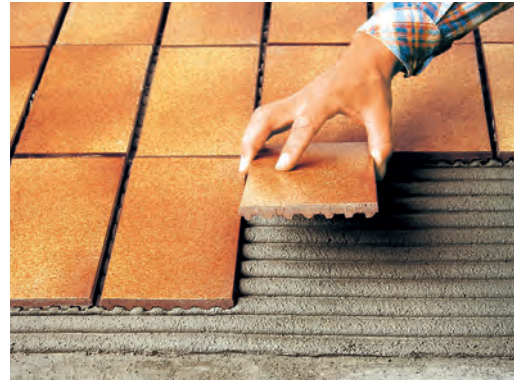
Spaltplatten mit starker Rückseitenprofilierung im Mittelbett
