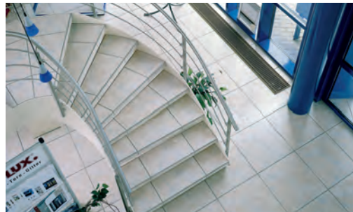
Belagtreppe in Form einer halben Wendeltreppe
