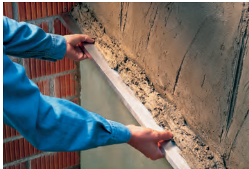
Schnelllehen erleichtern das Herstellen eines maßgenauen Putzuntergrundes
