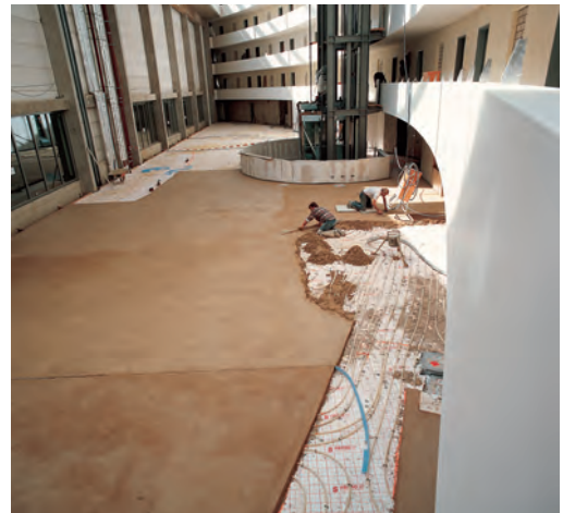
Konventioneller Calciumsulfatestrich als Heizestrich, (fugenlos) eingebracht in einer Hotelhalle
