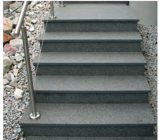
Plattenstufen aus Gabbro (Impala) auf einer Stahlbetonplatte; Oberflächen rutschhemmend beflammt und gebürstet
