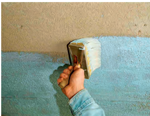
Vorstreichen eines gipsgebundenen Untergrundes mit einer Schutzgrundierung
