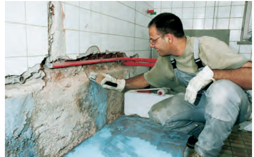
Einbürsten und Anlösen der Öle
