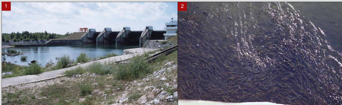
Slika 16. Prekid riječne cjelovitosti; 1/ brana akumulacije na Dravi, 2/ onemogućene longitudinalne migracije riba na rijeci Dravi (FOTO P. MUSTAČIĆ)
