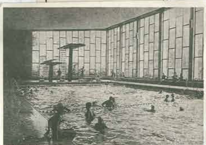
Mit Manzkebeton Hallenschwimmbad am Kurpark
