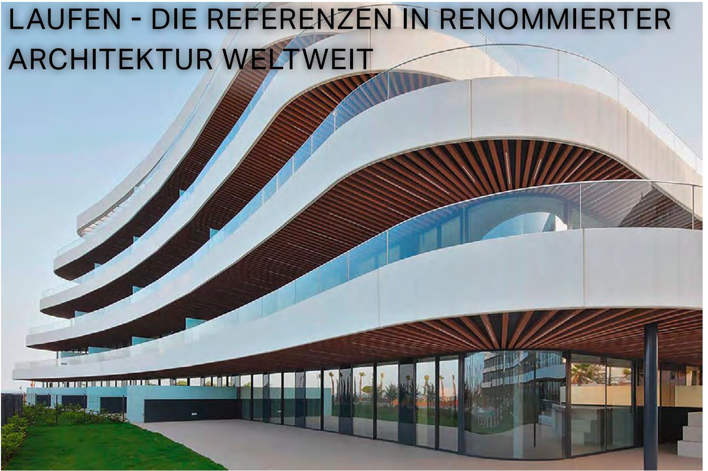
Residential Nereidas - Badwanne und WC LAUFEN PRO, Waschtisch PALOMBA Spanien Architektur: HCP y Arquitectos Asociados S.L.
