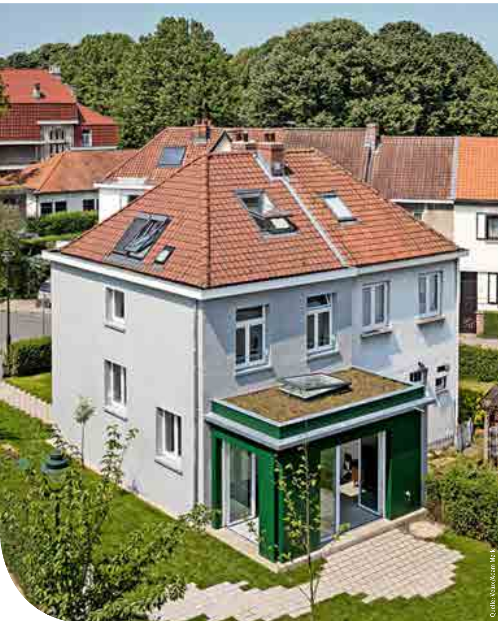
Die im Anderlechter Stadtteil Bon Air gelegene Doppelhaushälfte aus den 1920er Jahren nach der Sanierung mit Anbau
