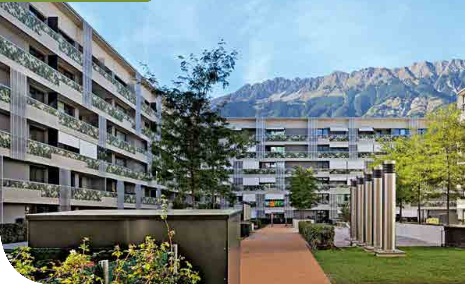
Malerisch vor den Alpen gelegen und energieeffizient: das Lodenareal der Neuen Heimat Tirol in Innsbruck
