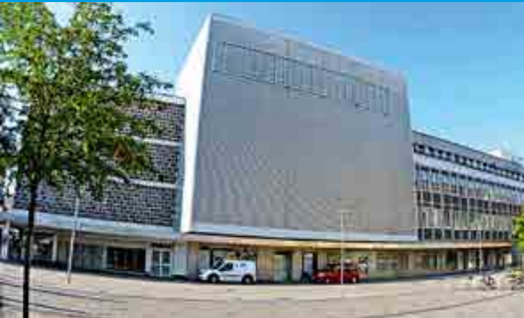
Der ehemalige Kaufhof am Aufseßplatz wird ab 2015 revitalisiert.
