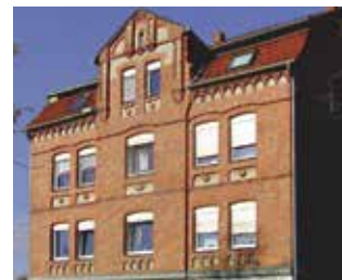
Bild 4 Die Klinker-Fassade wurde mit Isophob- F hydrophobiert.
