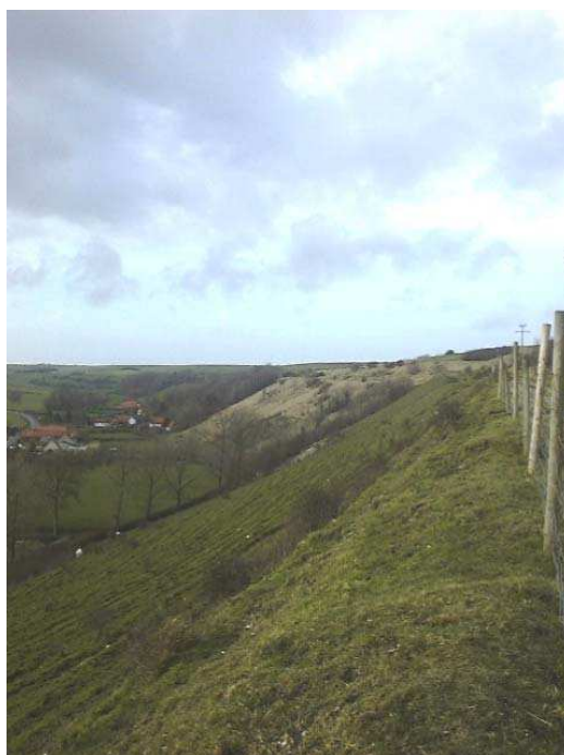
Photo n 7 : partie sommitale du coteau d'Acquin (ALFA, 2003).
