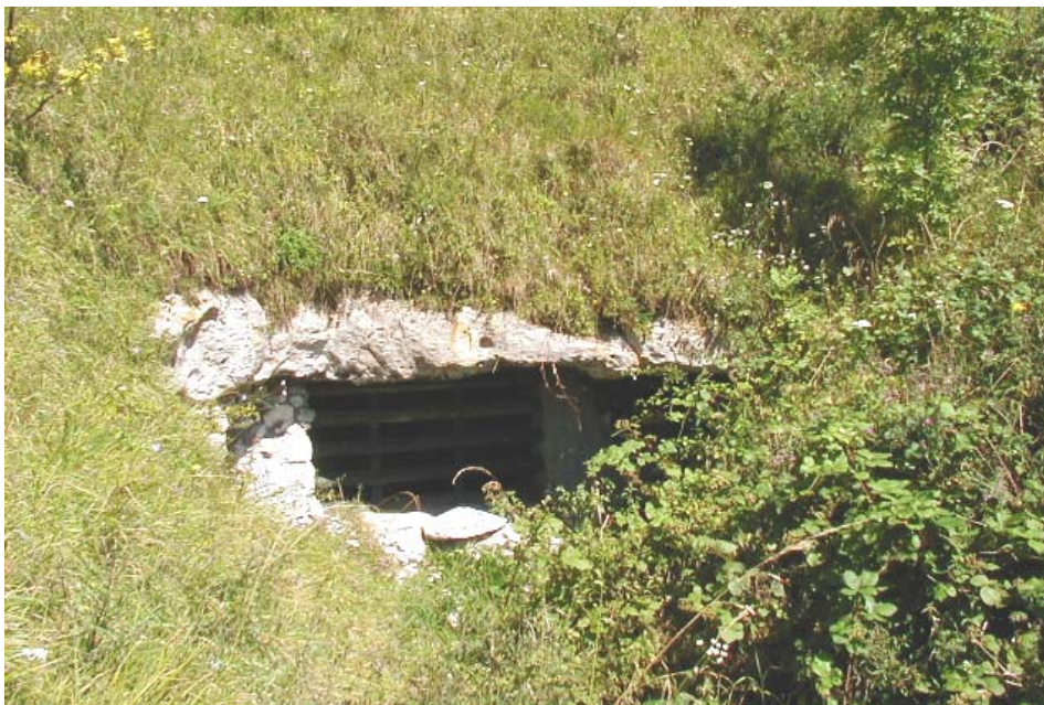
Photo n°8 : l'entrée de la grotte, aménagée depuis 1997 (P.Levisse, 2004).
