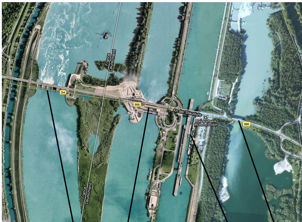
6.a. ábra Duzzasztómű Erőtelep csőturbinákkal hajózsilip között Folyami erőmű elrendezése a Rajnán Iffezheim városka mellett.
