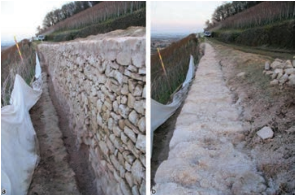
Abb. 7.10: Stabilisierung einer Trockenmauer durch Verfugungsmaßnahmen sowie Fundamentsicherung und Instandsetzung der Mauerkrone
