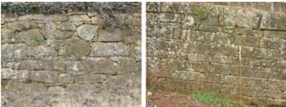
Abb. 3.3: Zyklopenmauerwerk (teilgeschichtet) im Ehrenstetter Ölberg bei Ehrenkirchen (a) und Schichtenmauerwerk im Brotwasserweinberg in Stetten im Remstal (b)
