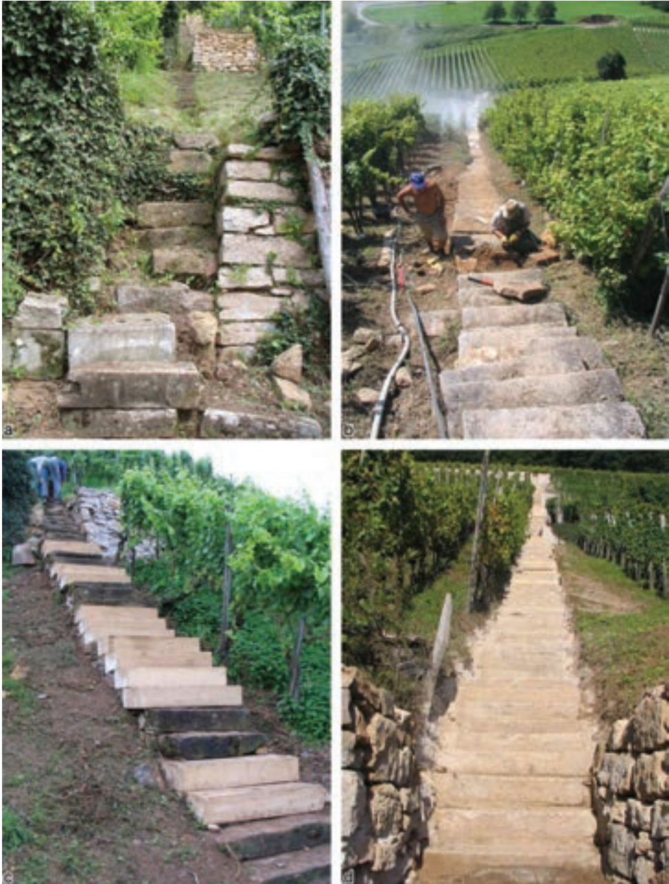
Abb. 9.2: Die verschiedenen Phasen der Treppensanierung am Castellberg: Treppe vor der Sanierung (a), Sandstrahlen und Entfernen defekter Stufen (b), Setzen neuer Stufen (c), Treppe nach der Sanierung (d)
