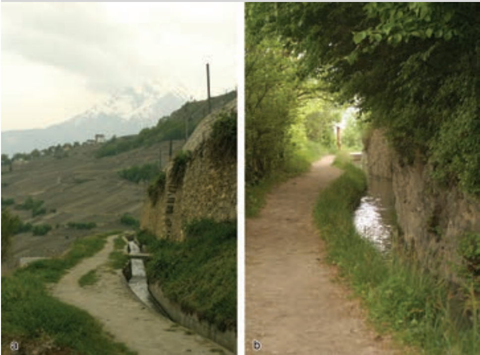
Abb. 3.33: In den Weinbergen des Wallis dienen Suonen zur Bewässerung der Rebflächen (Bisse de Clavau bei Sion, a und b)
