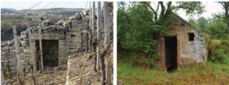
Abb. 3.20: Unterstand in einem Steinriegel mit einer Steinplatte als Decke bei Besigheim (a), Wengertschützenunterstand bei Maulbronn-Zaisersweiher (b)
