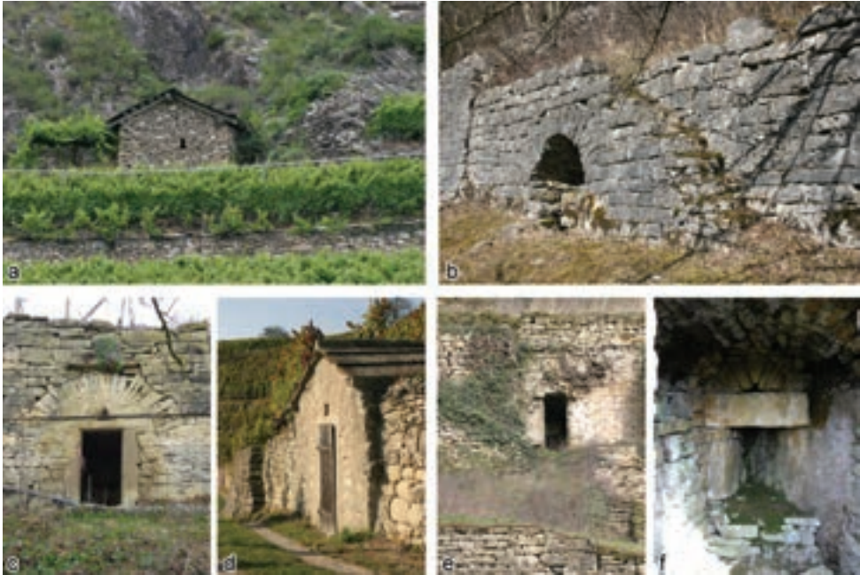
Abb. 3.19: Trocken gemauertes Weinbergshäuschen im Wallis (a) und Unterstände mit Natursteingewölben in Neckarzimmern (b), Vaihingen/Enz-Enzweihingen (c), Mühlacker-Mühlhausen (d), und in den Mindener Layen bei Irrel in der Eifel mit Innenansicht auf einen Kamin (e und f)
