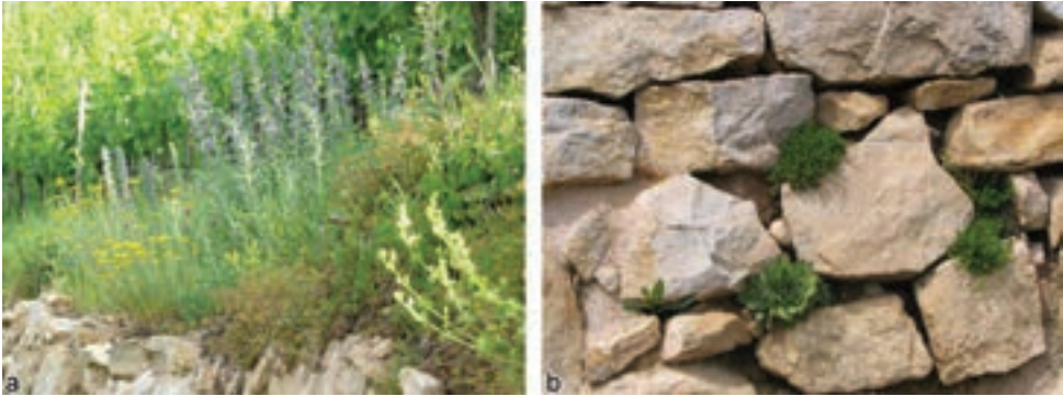
Abb. 7.14: Artenreiche Mauerkronevegetation aus REGIO-Saatgut (a) und Wiederbelebung einer sanierten Mauer durch neu angesiedelte Sukkulenten (b)
