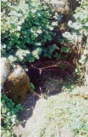
Abb. 3.31: Gemauertes, kleines Absetzbecken am Fuß eines Weinbergs (Widdern/Jagst)
