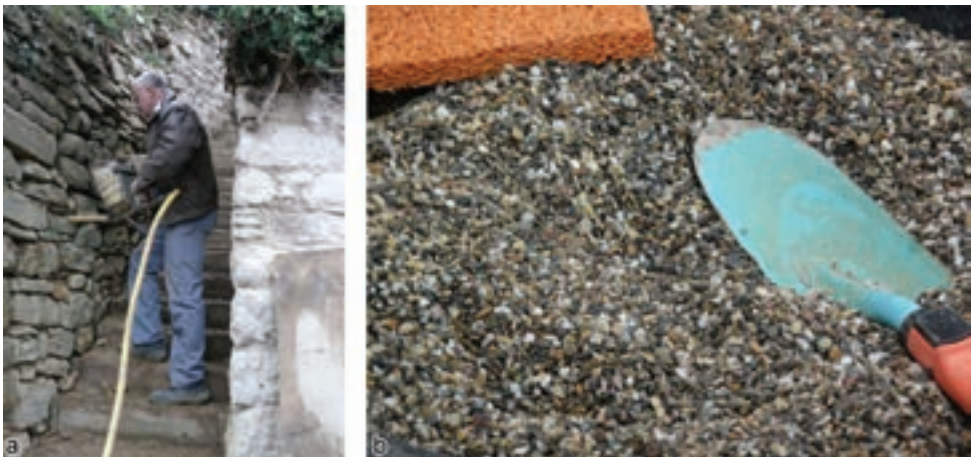
Abb. 7.13: Füllung der Hohlräume einer sanierten Treppenmauer am Castellberg (a) und der hierfür verwendete Splitt aus zerkleinertem Rheinschotter (b)
