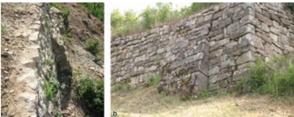
Abb. 3.16: Mauerpfeiler am Castellberg in Ballrechten-Dottingen (a) und am Gambacher Kalbenstein bei Karlstadt am Main (b)
