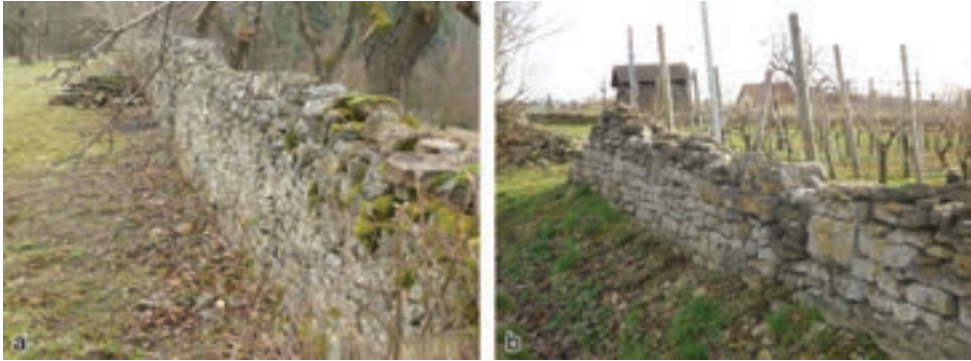
Abb. 3.25: Freistehende Weinbergstrockenmauern bei Markgröningen-Talhausen (a) und Besigheim (b)
