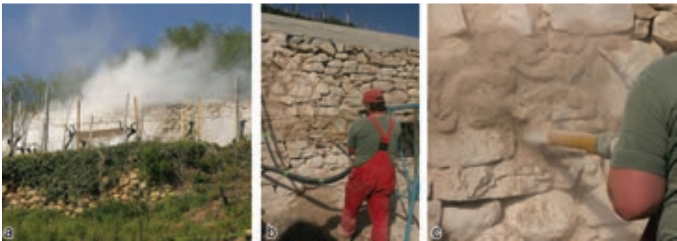
Abb. 7.8: Sandstrahlen zum Reinigen der Trockenmauern (a) und Verfügung im Hochdruckspritzverfahren (b und c)
