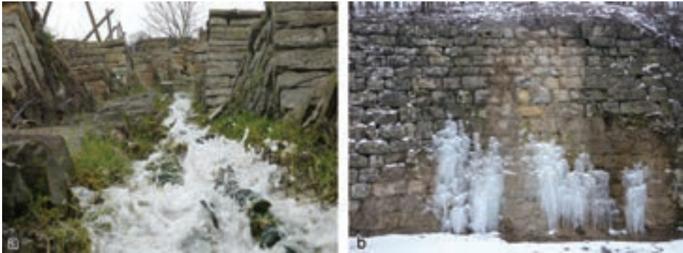
Abb. 3.27: Wasser im Weinberg: Ableitung über Rinnen (Vaihingen/Enz-Enzweihingen, a) und Drainagefunktion einer Trockenmauer, die bei Frost im Winter gut erkennbar ist (Stadtbredimus/Luxemburg, b)
