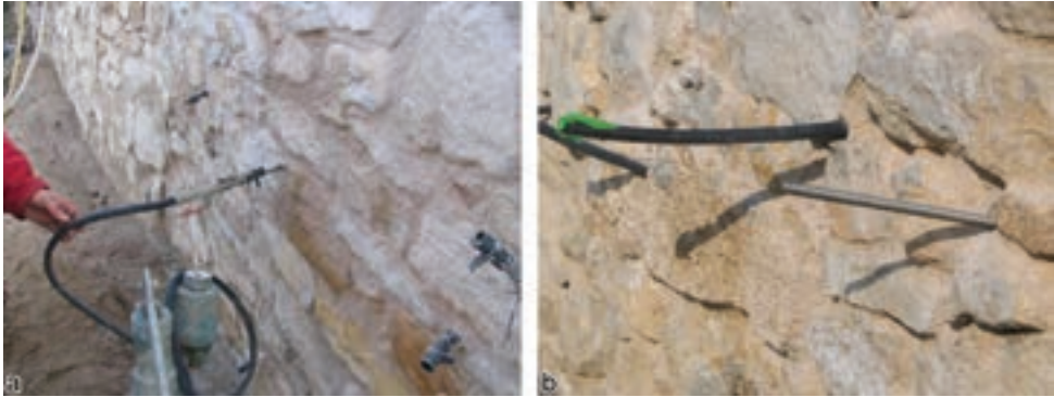
Abb. 7.11: Injektion von Trasskalk (a), Einfüllstutzen und Nadelanker (b)
