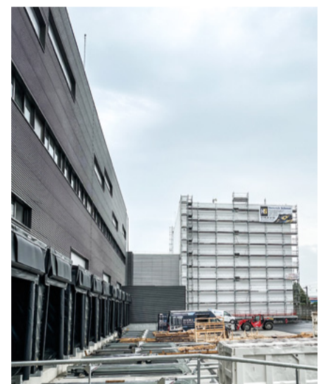
Komplexe Fassade: An der Langseite arbeiteten die Maler mit einem Seilgerüst. ▶
