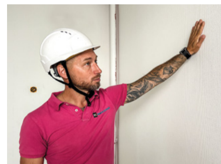
▲ Auge fürs Detail: Metzger prüft die Glasgewebetapeten in den Büroräumen.
