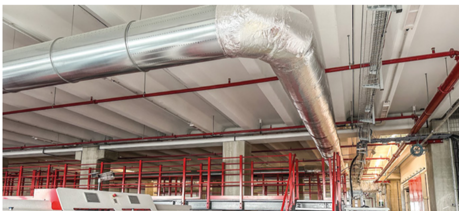
▲ Beim Beschichten der Decken kam moderne Spritztechnik zum Einsatz.
