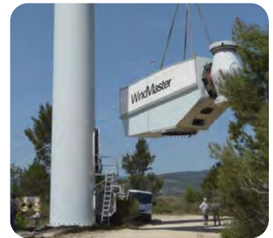
Démantèlement du parc éolien de Sallèles Limousin (Avril 2010) - Source EDF EN
