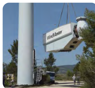
Démantèlement du parc éolien de Sallèles Limousis (Avril 2010) - Source EDF-EN
