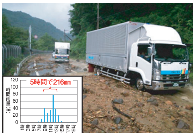
図-3 国道46号 岩手県雫石町 (H25.8.9)
