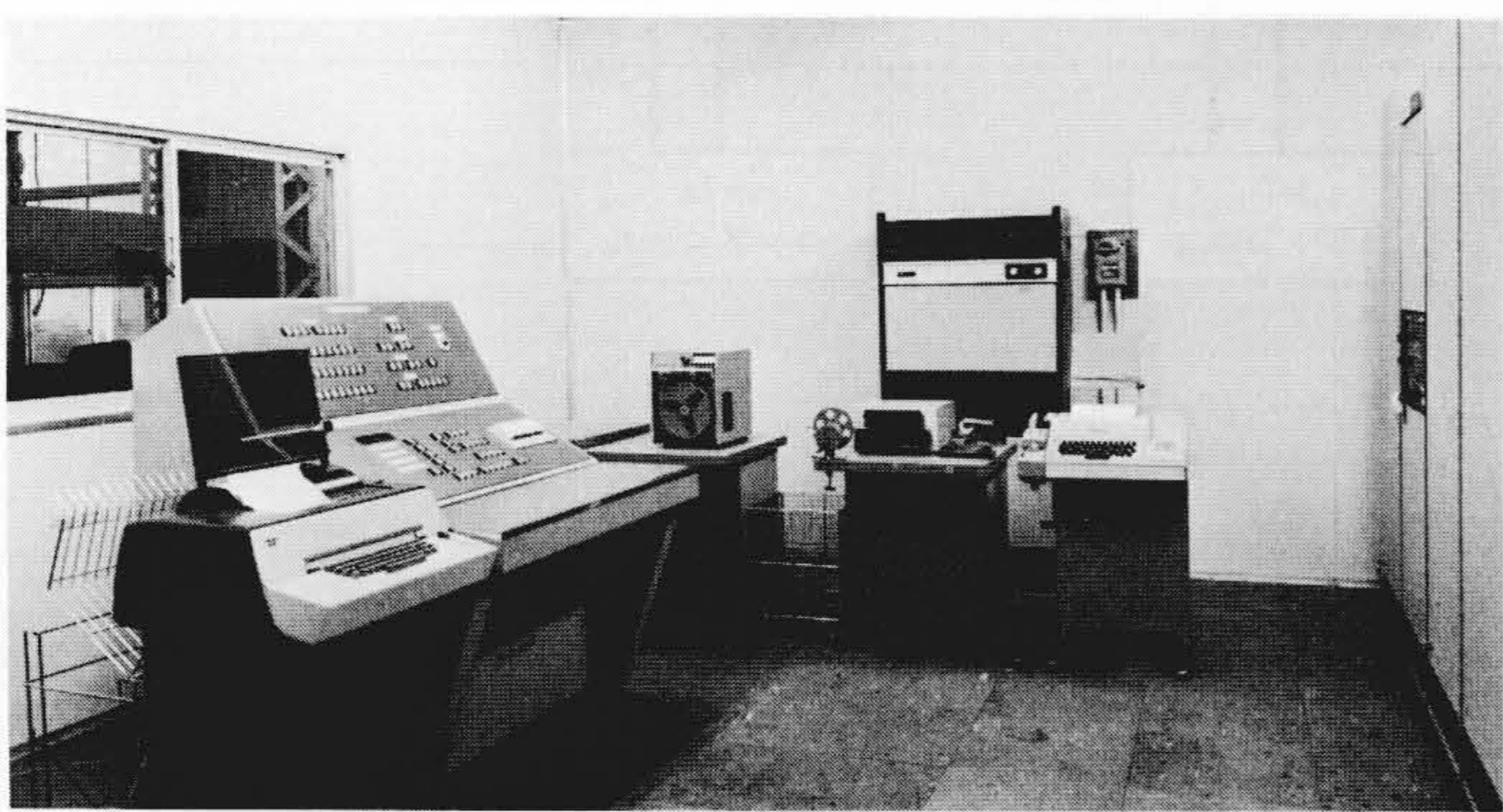
図6 計算機システム概観図 電子計算機室のレイアウト概観であり、キュービクル面数8面、システム操作卓、ロギング タイプライタ、コンソール入・出力装置及び紙テープパンチャがある。
