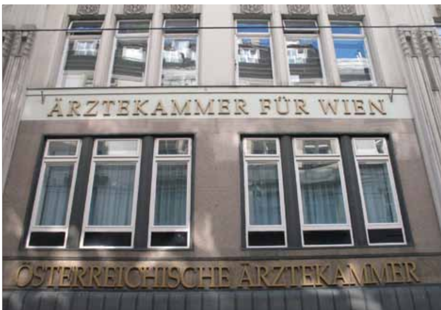
Zgrada Liječničke komore u Beču
