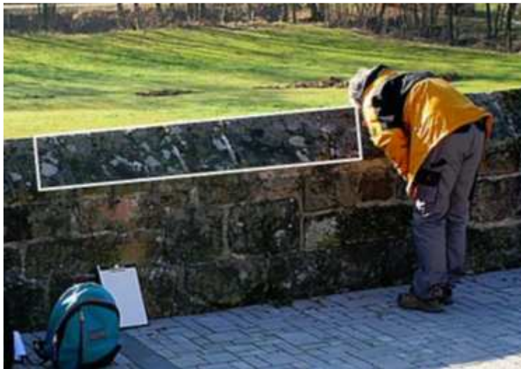
Abb. 9: Untersuchung einer Natursteinmauer auf Flechten
