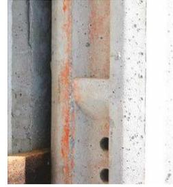
Figura 9.5 Detalle de ménsula para apoyo de primera baldosa
