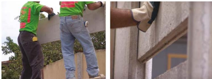
Figura 9.40 Colocación de baldosas en sitio
