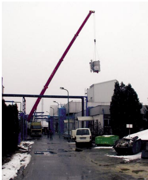
2. kép: A tablettázó beemelése
