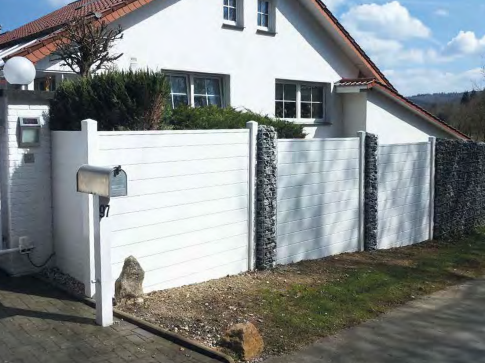
Uno fix mit Gabionen-Elementen, vom Kunden bauseits in der Höhe angepasst
