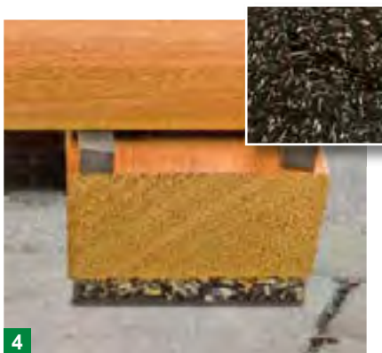
4 Gummi reguliert: Höhenausgleich-Pads für die Unterkonstruktion.
