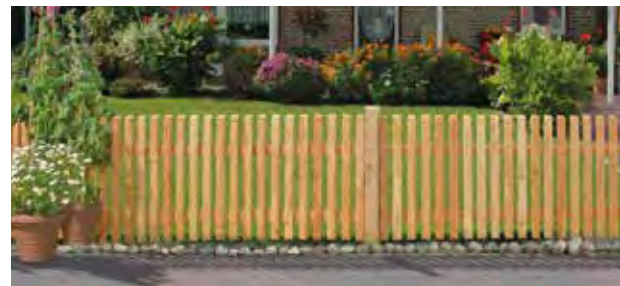
Lattenzaun aus Lärche
