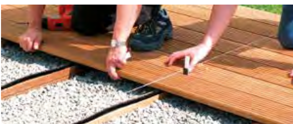
Lehre für gleiche Fugenabstände
