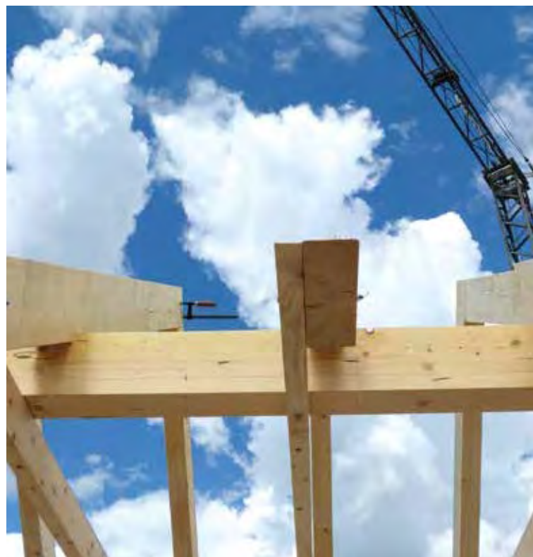
Ein Dachstuhl entsteht: Moderner Holzbau mit dem Naturbaustoff Fichte NSI
