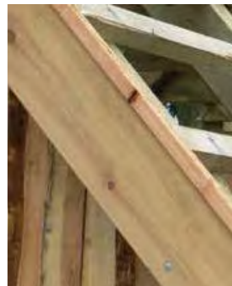
Lärche – Dachstuhl im Detail
