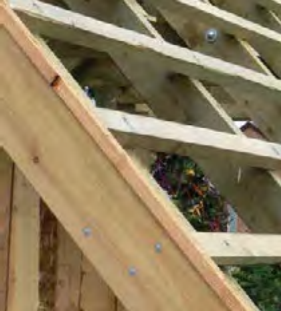
Lärche – Dachstuhl im Detail
