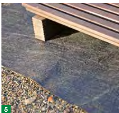
5 Wasserdurchlässiges Abdeckvlies gegen Durchwurzelung u. Pfützenbildung.
