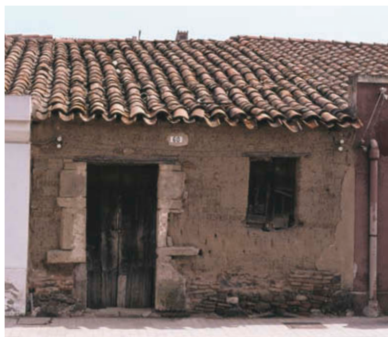
186. Facciata del laboratorio del figolo Giovanni Manca, adiacente all'abitazione, Oristano, 1976 (foto Herman Geertman, archivio M.B. Annis). Abitazione e laboratorio avevano in comune il cortile dove si trovava il forno.
