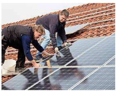
Dringend gesucht: Dachdecker, die Photovoltaikanlagen montieren können.
