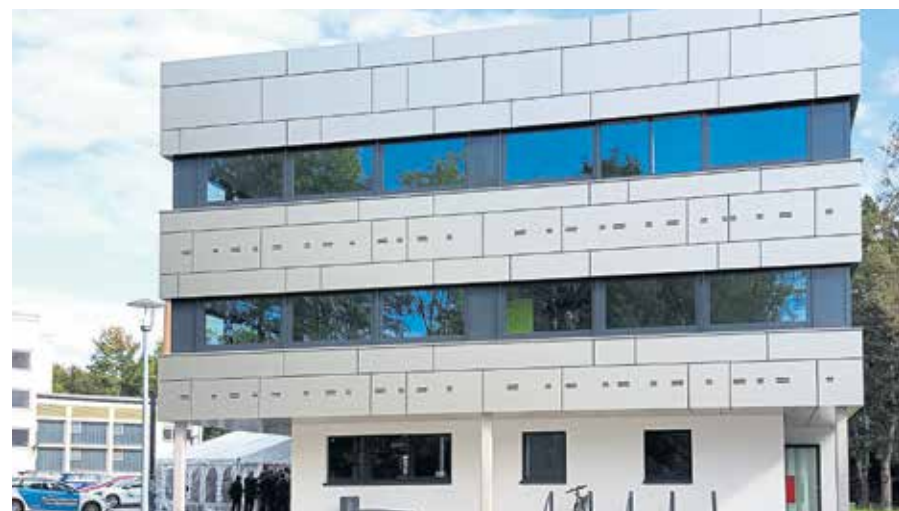
Die neuen Seminarräume am Ufer der Donau. Fotos: Bouß
