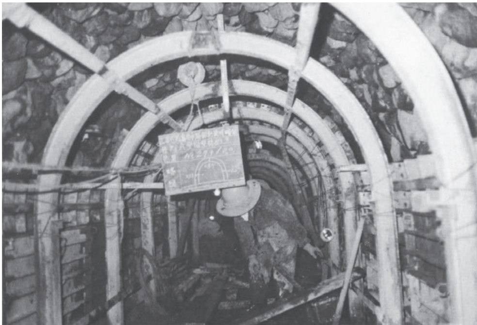
御勅使川暗渠工事写真（関東農政局 1974『釜無川』より）
