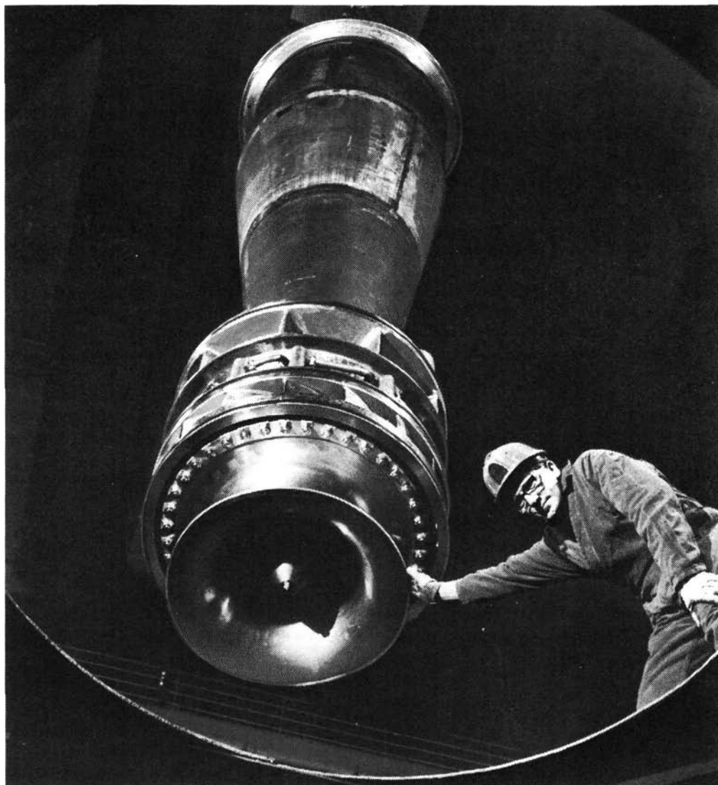
Montaje de la bomba primaria en el prototipo de reactor rápido de 250 MW(e), cuya construcción acaba de terminarse en Dounreay, Caithness (Escocia) . . . UK Atomic Energy Authority.
