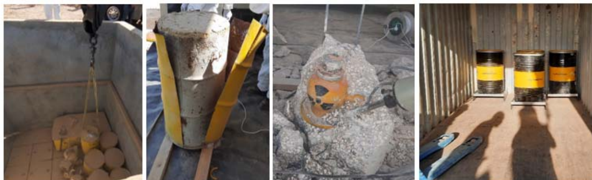
图 C.4. 在约旦一个遗留废物贮存场址回取放射源并将其整备到新废物包装中。 (照片来源：约旦原子能委员会)
