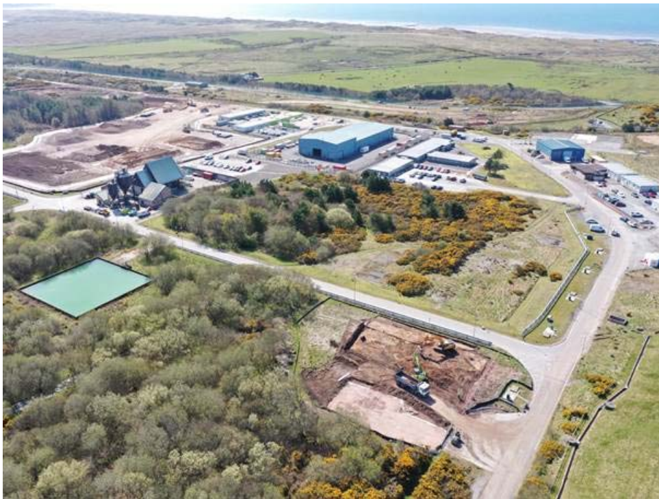
图 C.3. 在英国低放废物处置库为支持在设施的一部分加装最后覆盖层进行的准备工作。（图片来源：英国核退役管理局，2021 年）
