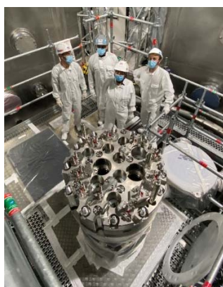
图 D.1b. 在法国卡拉奇安装儒勒·霍洛维茨反应堆的封盖。（照片来源：法国原子能委员会）
