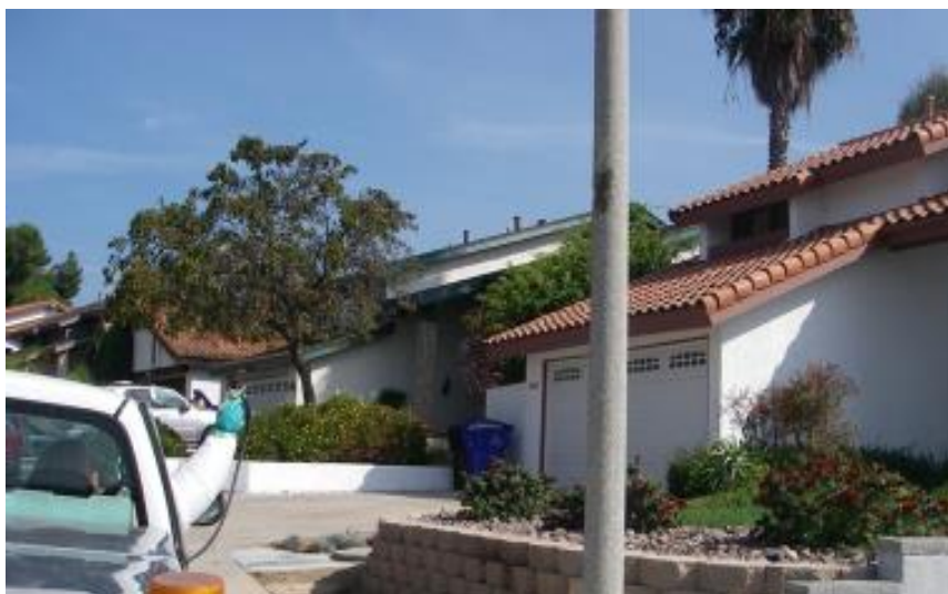
Figura 3. Aplicación de mancha focalizada sobre poste de luz.
