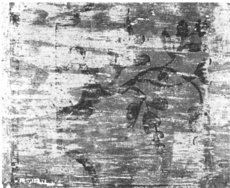
Fig. 8. — Décoration peinte sous-jacente des lambris du petit salon (n° 13) apparue lors d'un essai de dégagement. (Cliché F. Niffle. Liège.)
