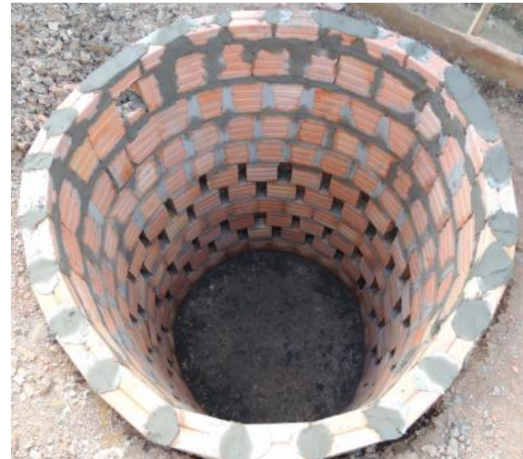
Pozos de Infiltración
