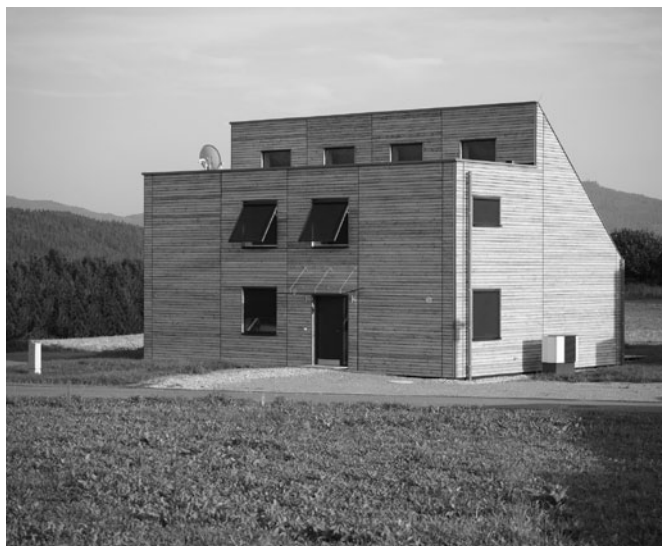
Abb. 3+4: Nordwest und Südwestansicht. Fotos: © Sonnenkraft
