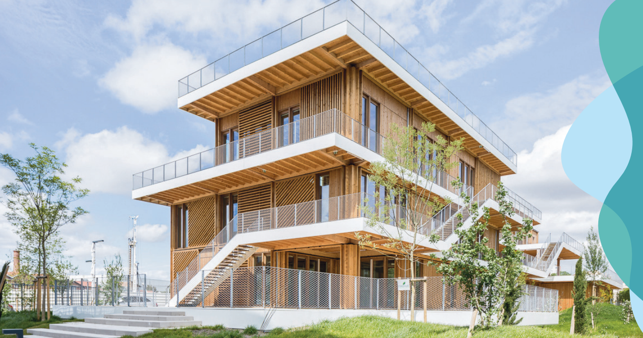
Maison des services - Latécoère (Toulouse)
