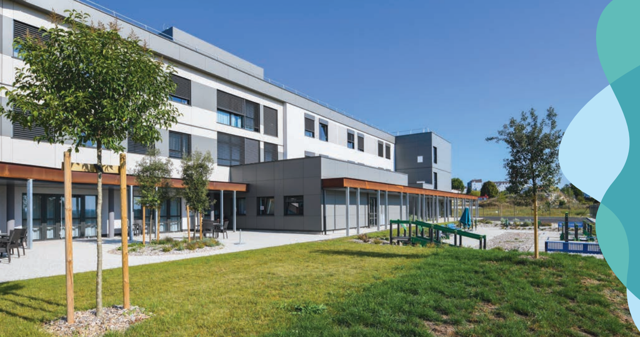
Sur Moreau PAC facility, Saintes
